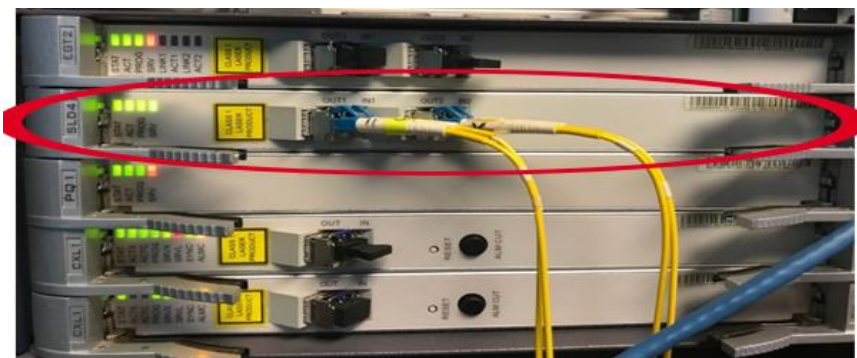
Figura 2.13 Conexión en tarjeta SLD4.
