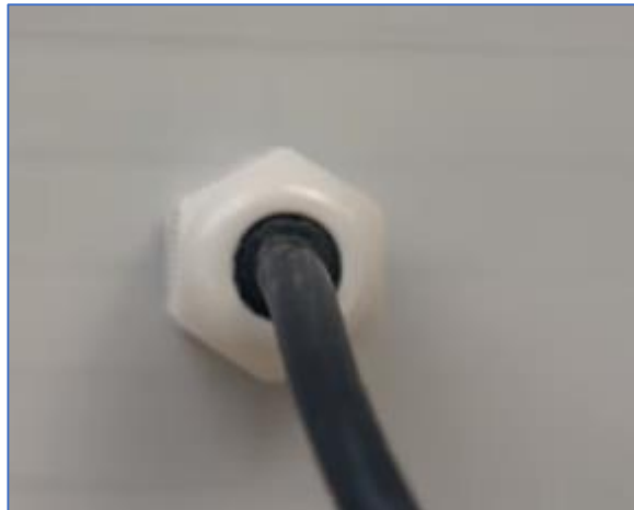
Figura 3.3. Instalación de prensa estopa [5].
