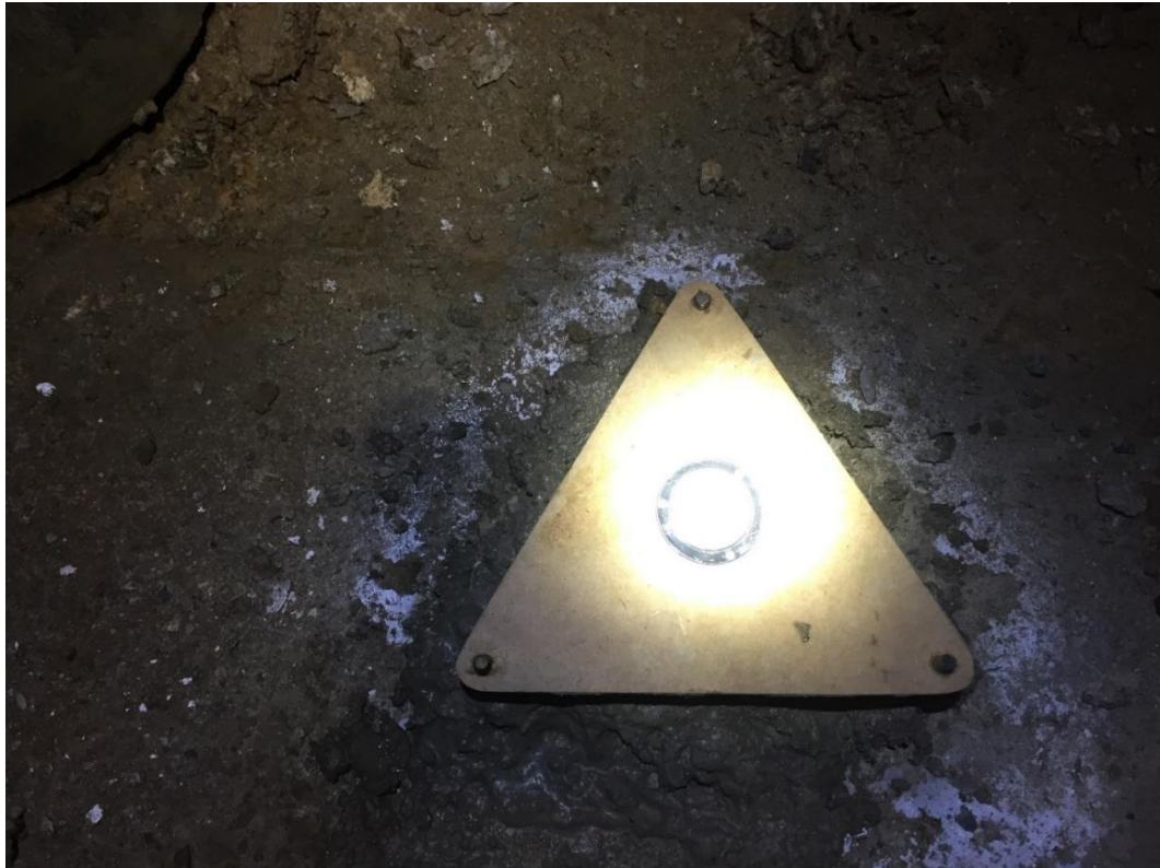
Figura 4.5 Triangulo MDF nivelado antes de empotrarlo al piso de la galería
