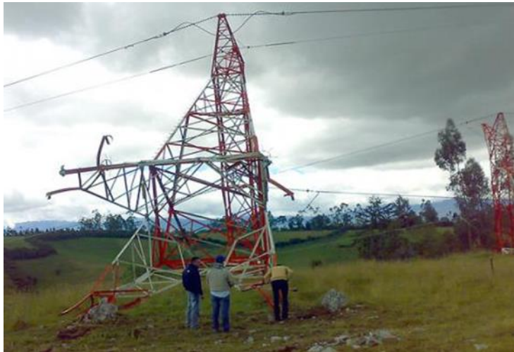
Figura 2.4 Contingencia producida por la caída de una torre de transmisión de energía eléctrica
