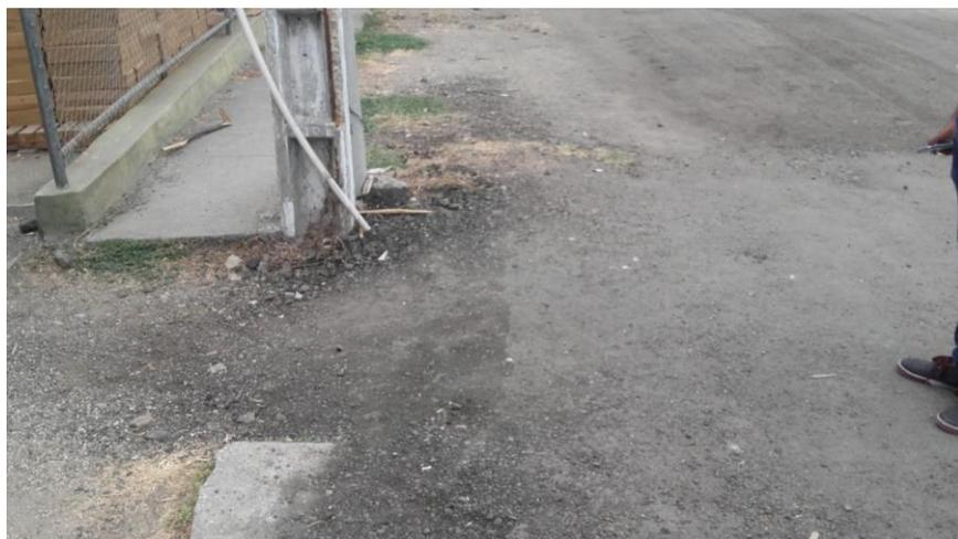
**Figura 5.48 Cámara CP7 cubierta de hormigón asfáltico.**
