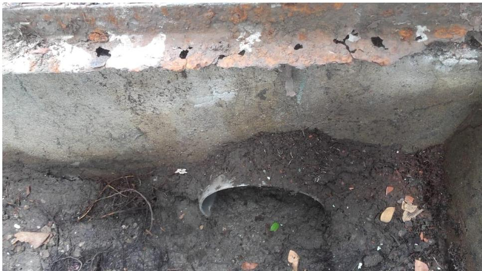
**Figura 5.77 Vista de tubería colapsada de la caja RSI3**
