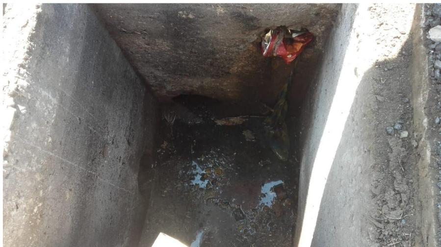
**Figura 5.39 Presencia de basura en tuberías de la cámara CP2.**
