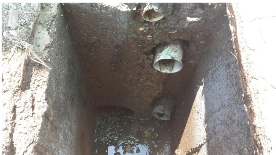
**Figura 5.46 Vista de las tuberías que aportan caudal a la cámara CP5.**
