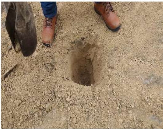
Calicata para extraer muestra
