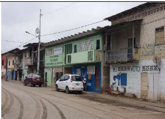
Subcentro de Salud ubicado en Simón Bolívar
