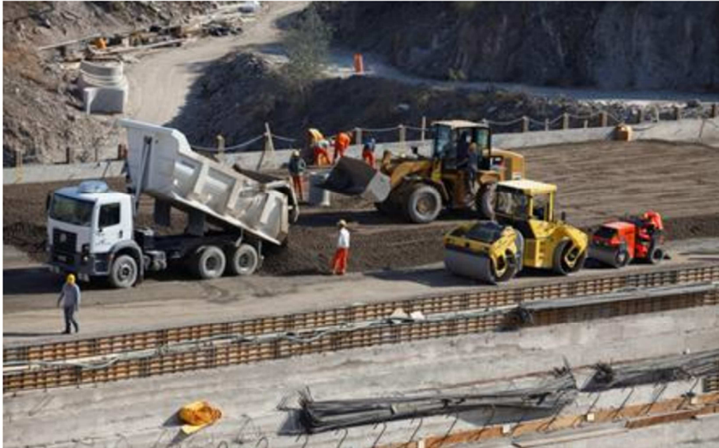
Figura 1 Transporte, colocación y compactación del HCR
