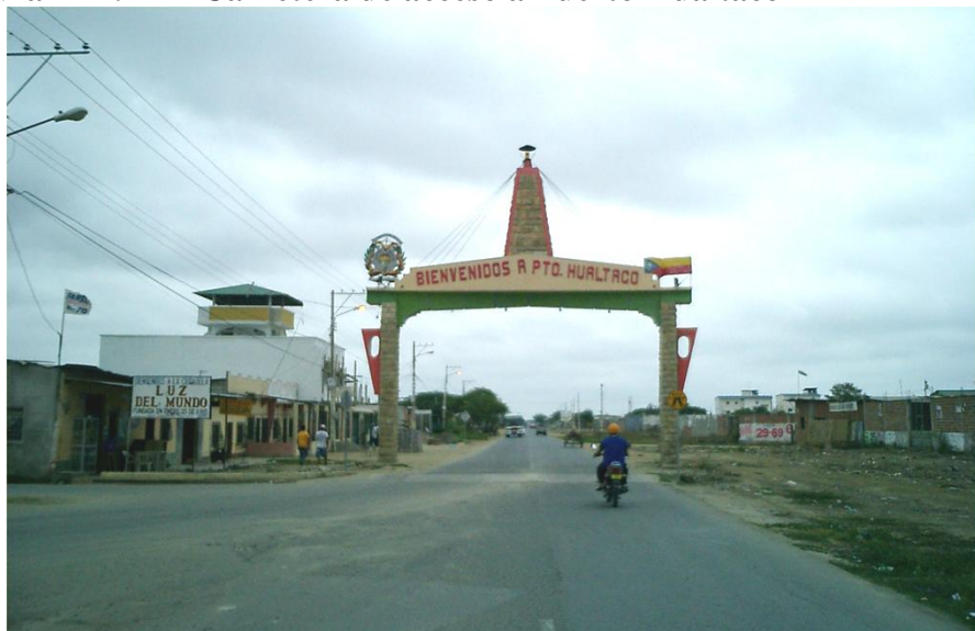
Figura # 24. Carretera de acceso a Puerto Hualtaco
