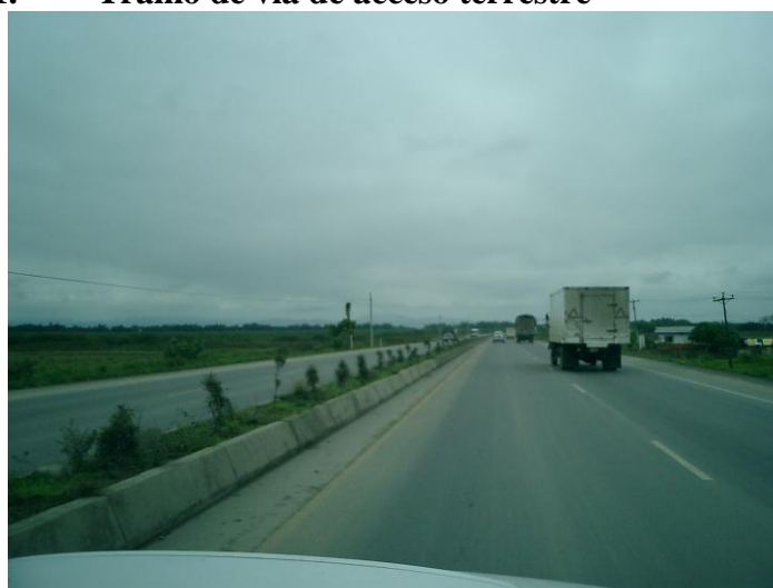
Figura # 21. Tramo de vía de acceso terrestre
