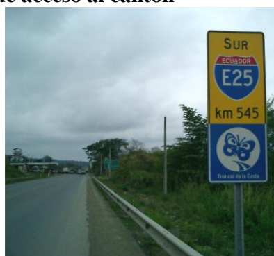
Figura # 20. Vía de acceso al cantón
