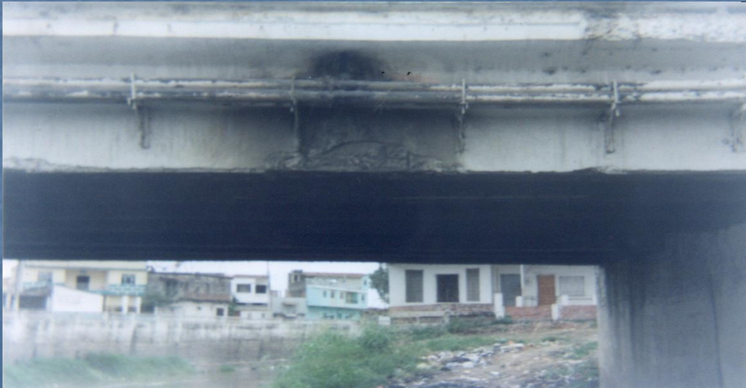
VIGA DE LA ESTRUCTURA ANTIGUA DEL PUENTE
