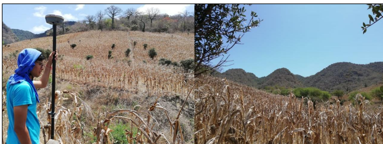
Figura 3. 18 Zona donde se construirá la Presa, fotos del levantamiento topográfico.
