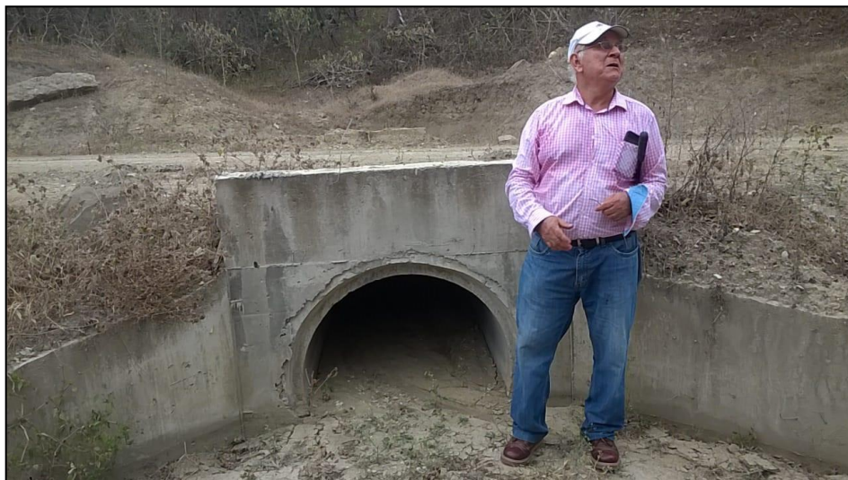
Figura 2. 2 Alcantarilla principal de unión de las Cuencas #1 y #2 con la Cuenca #3
