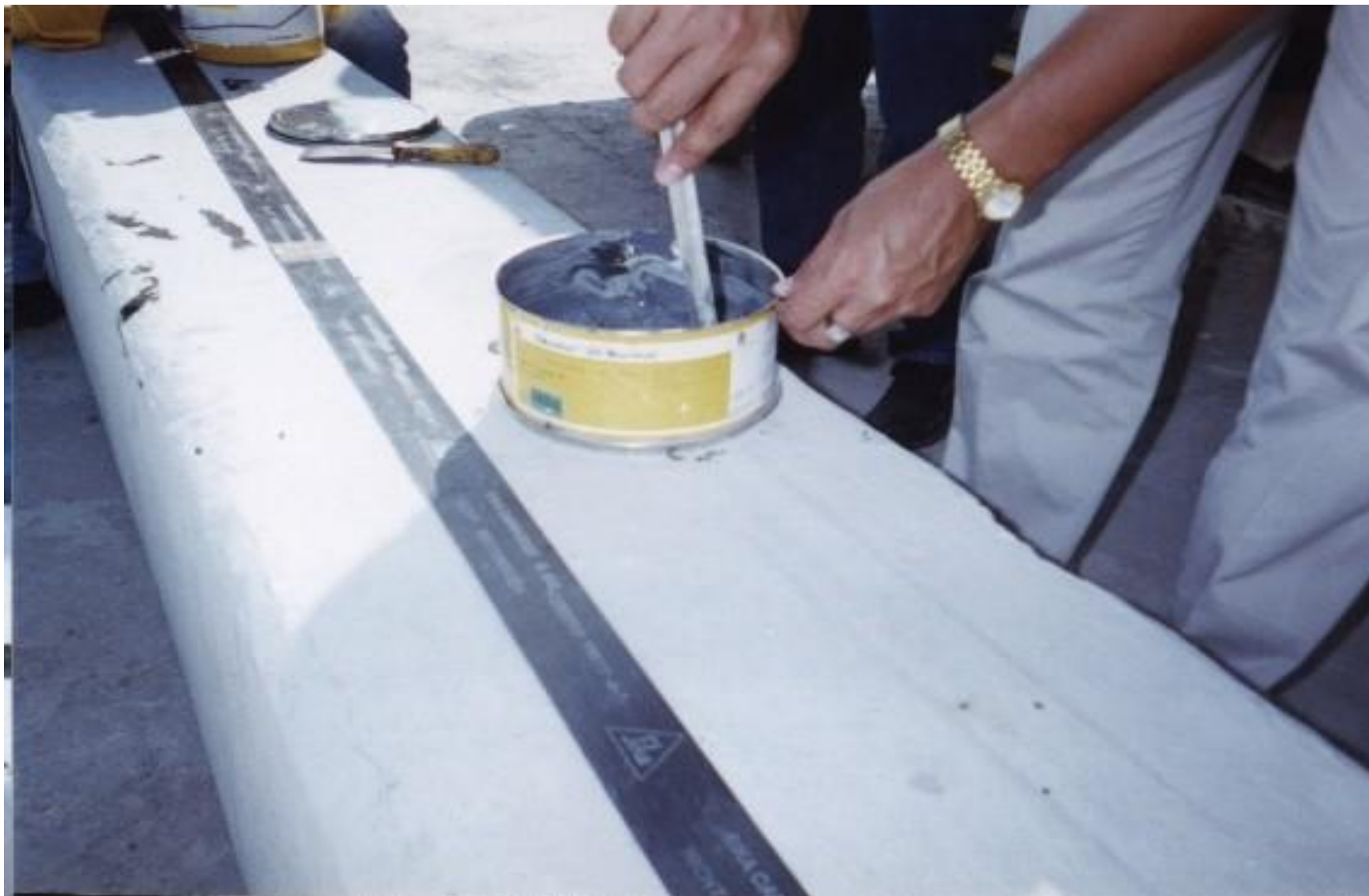
7. Mezcla del componente A y el componente B del adhesivo Sikadur-30.
