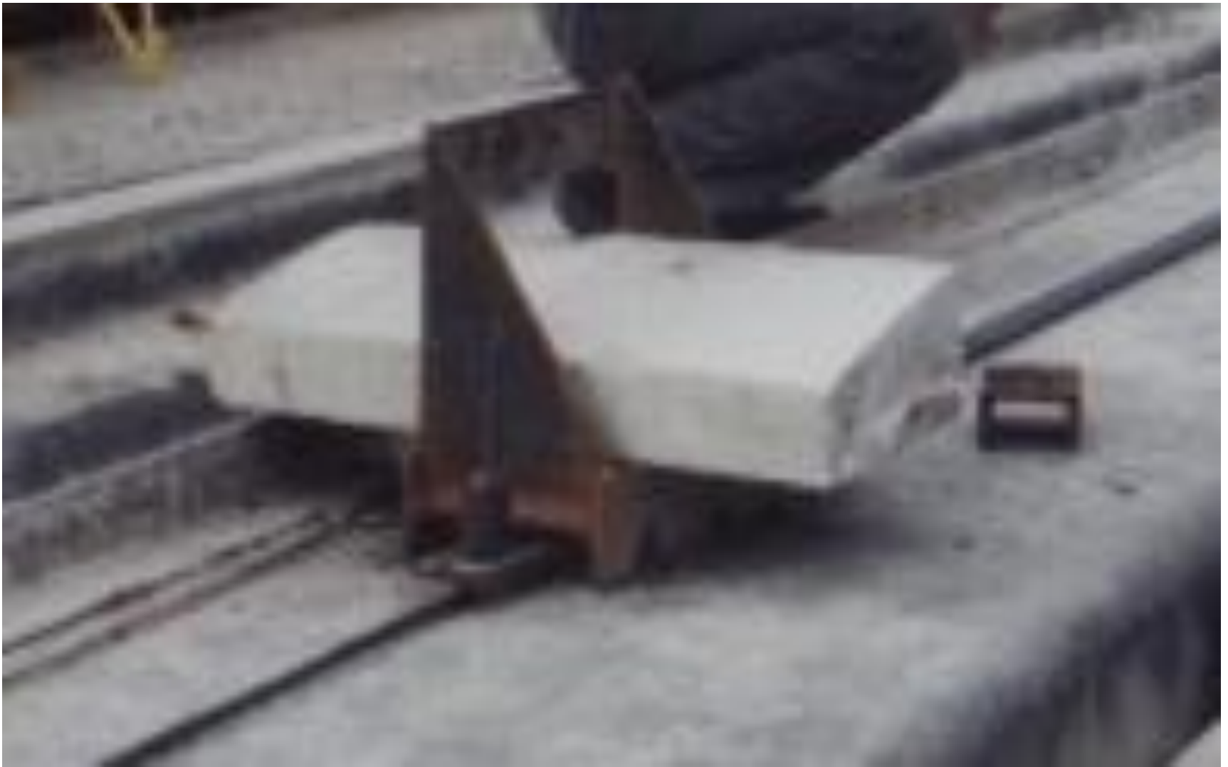
Foto 4.14. Elemento que restringe Movimiento Torsional.
