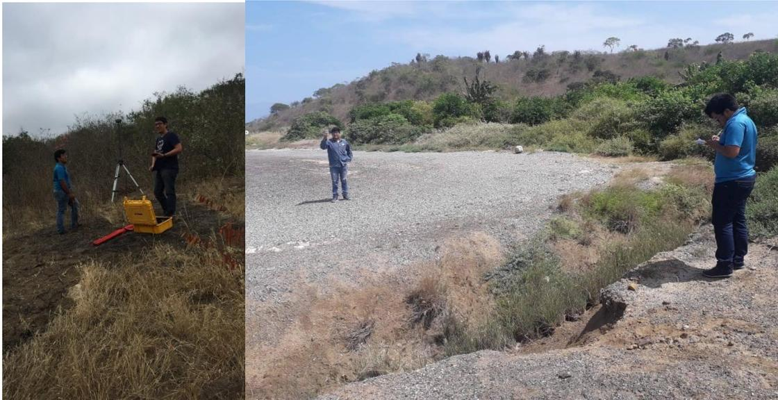
Figura 3.1 Levantamiento Topográfico con GPS diferencial y GPS de mano. Fuente: (Calderón & Mata, 2019)
