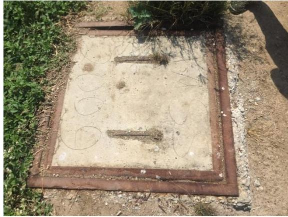
*Figura 1.4 Tapa de Hormigón AASS. Fuente: (Calderón & Mata, 2019)*
