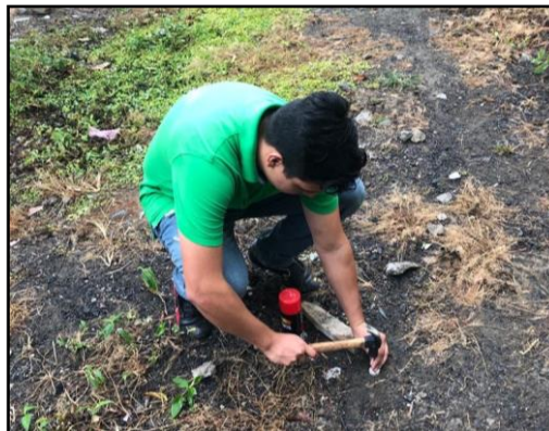
Figura 2.6 Colocación de la estación provisional [Carreño J., Cañarte J., 2019]
