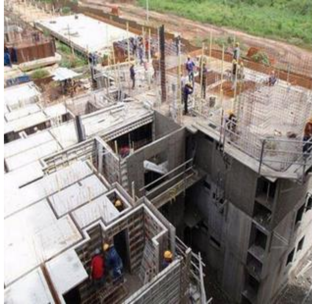
Ilustración 2 Utilización de muros estructurales en obra
