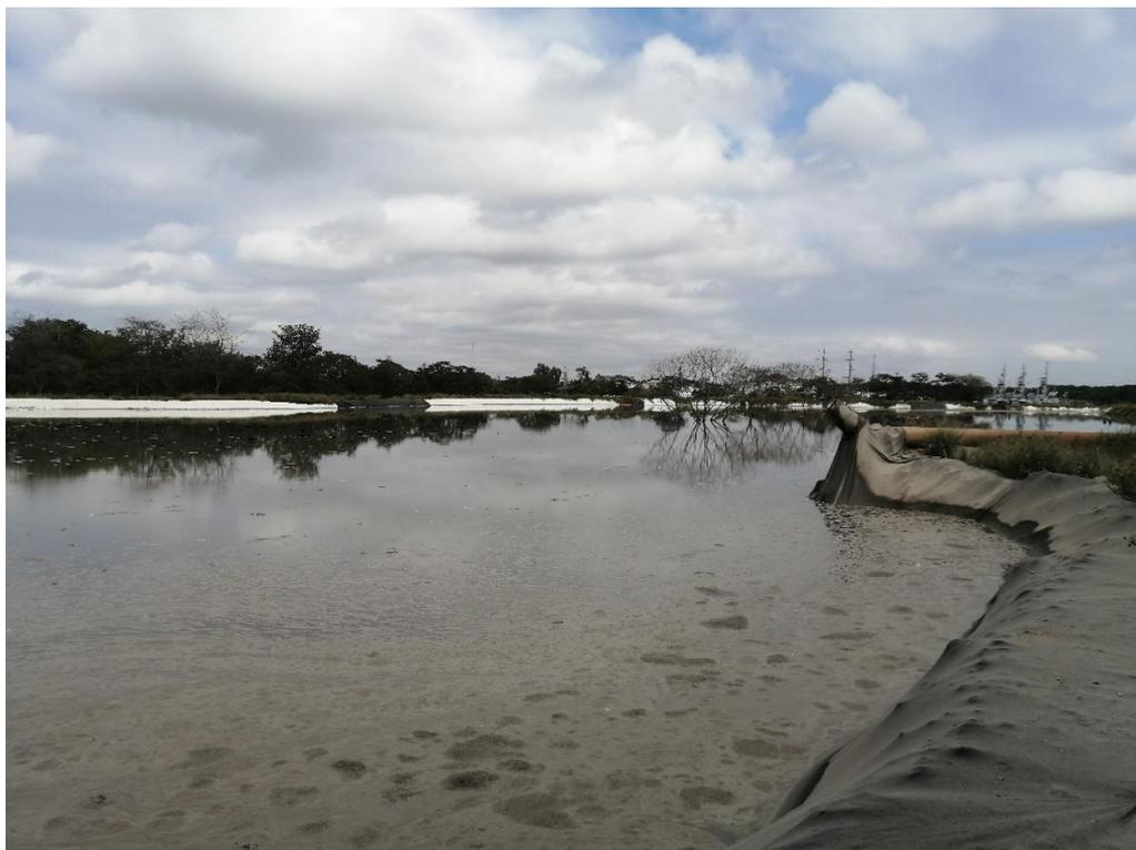
**Tubería ubicada en tierra, que se encarga de transportar el material dragado hasta el cuartel, fuente: autores**
