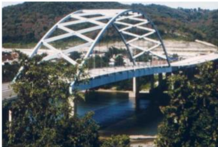
Figura 1.7 Puente tipo arco sobre el río Ohio. Fuente: (Federal Highway Administration, 2015)
