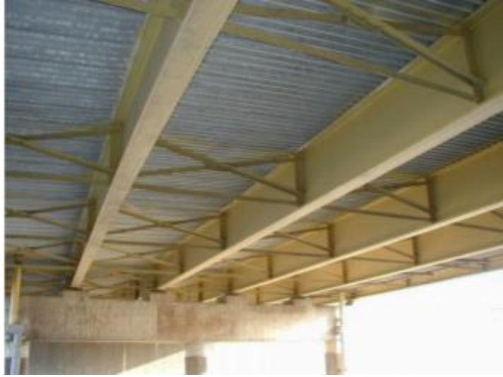
Figura 1.6 Puente tipo viga de sección compuesta. Fuente: (Federal Highway Administration, 2015, pág. 4)
