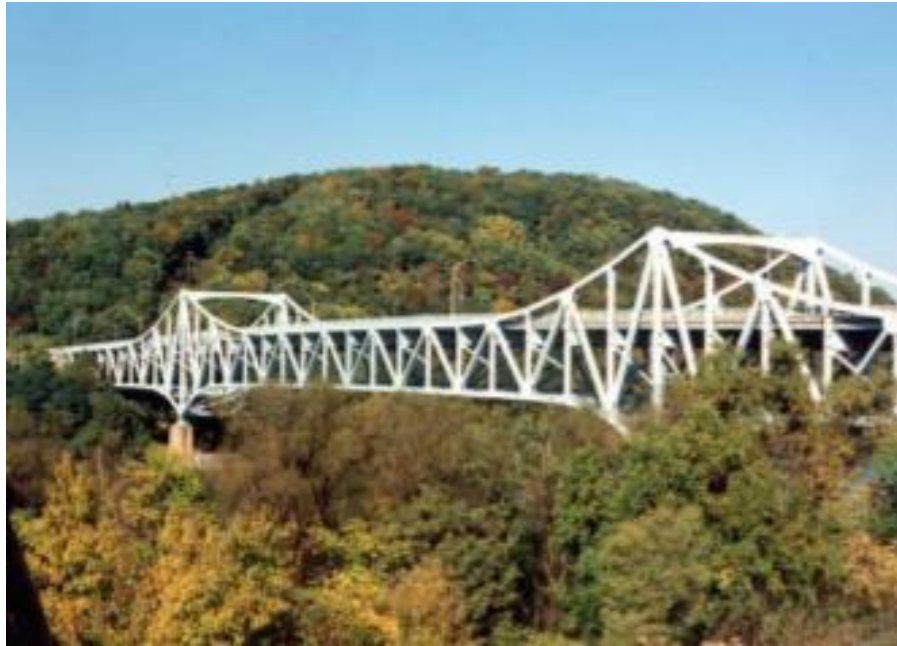
Figura 1.8 Puente tipo armadura sobre el río Monongahela. Fuente: (Federal Highway Administration, 2015, pág. 8)
