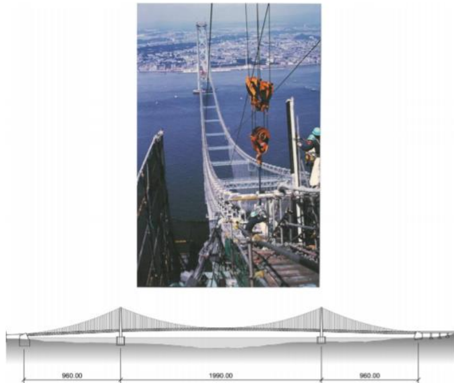
Figura 1.9 Puente Akashi Kaikyo. Fuente: (Pipinato, 2015, pág. 409)
