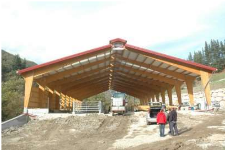
Figura 2.7 Galpón con pórticos de madera
