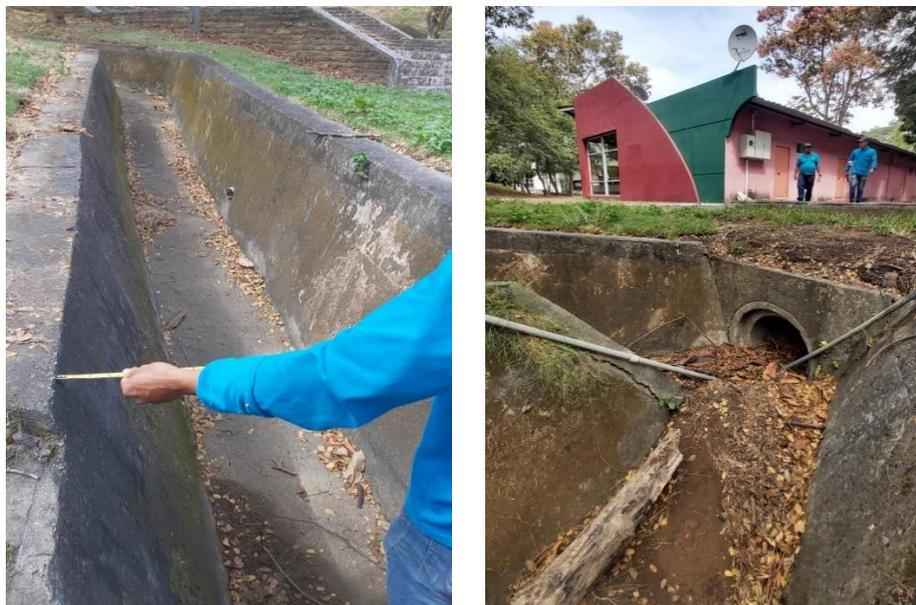
**Figura 3.18 Sección del Canal Existente y Tubería Receptora de AA.LL. ( $\varnothing 500$  mm) (Cruz & Hidalgo, 2021)**
