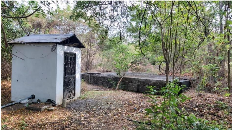
**Figura 2.21 Cisterna y cuarto de bomba para riego en SEBIOCA (Cruz & Hidalgo, 2021)**
