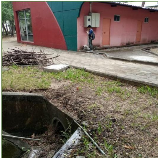
**Figura 2.34 Tubería receptora en Sweet & Coffee ( $\varnothing$  500 mm) (Cruz & Hidalgo, 2021)**
