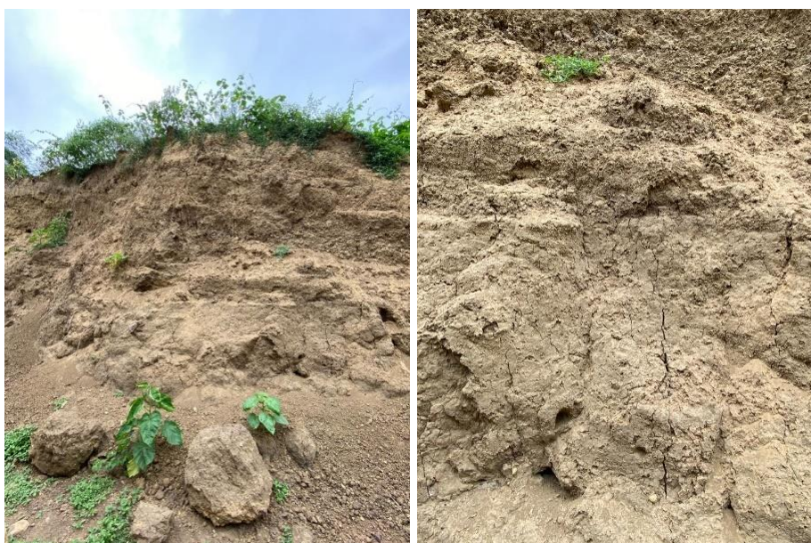
Figura 2.3 Detalle de material de relleno existente.
