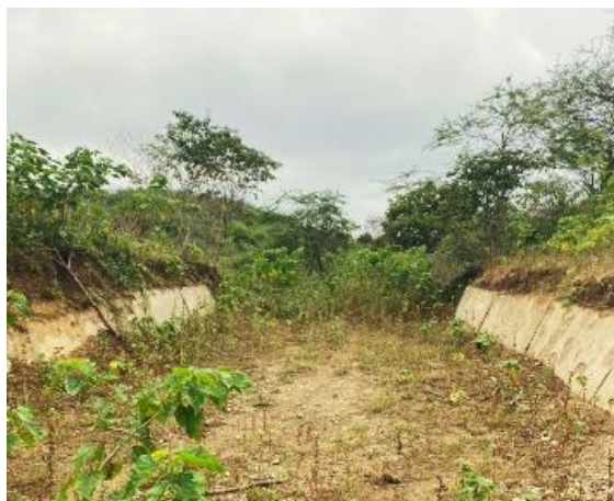
Figura 1.3 Estructura del aliviadero original. Fuente: Novillo R.; Stay, D. (2021)
