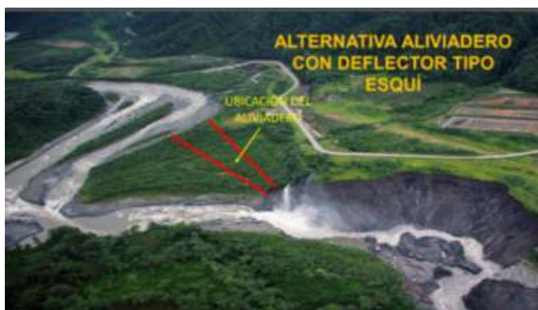
Figura 2.2 Esquema ilustrativo de posible solución 2. Aliviadero con reflector tipo esquí. (Washington et al., 2020)
