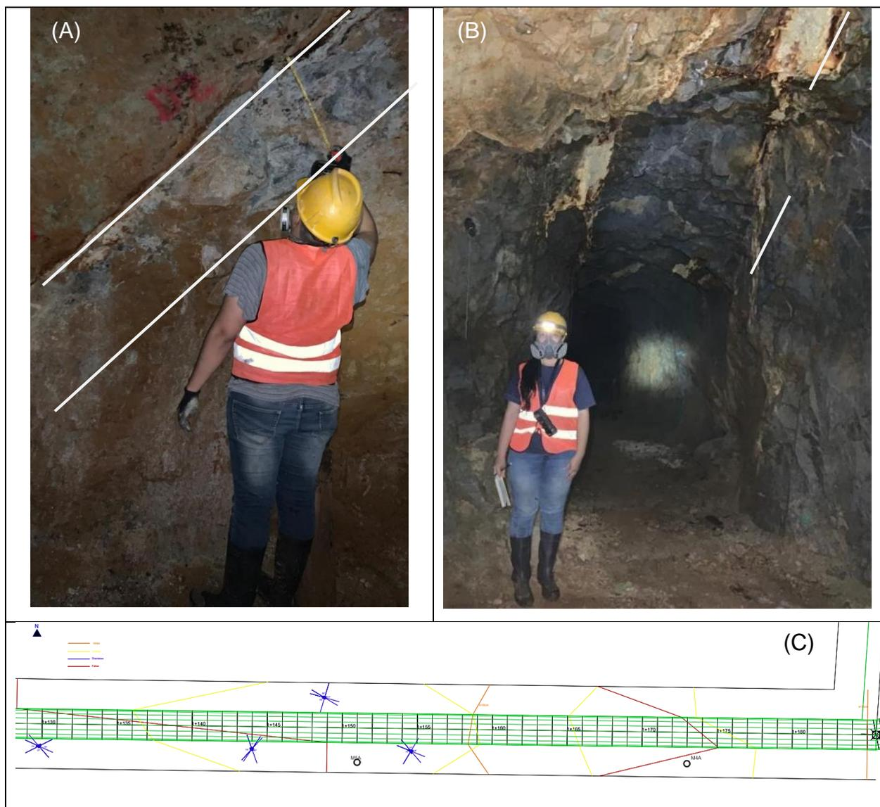
**Figura 5.3: Estructuras importantes Zona D. (A) Veta característica (Abs. 1+307. Flanco derecho). (B) Veta "1 Norte" (Abs. 1+182. Flanco izquierdo). (C) Representación en plano abatido de sistema de vetas importantes Zona D Fuente: autores**
