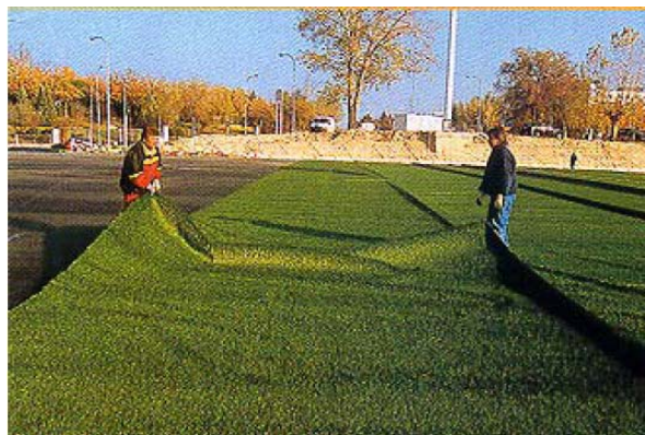
Figura No 2.6 Tendido de los Rollos
