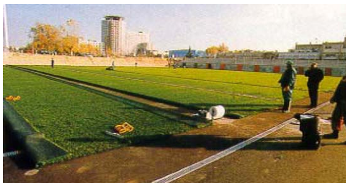
Figura No 2.7 Unión de Rollos
