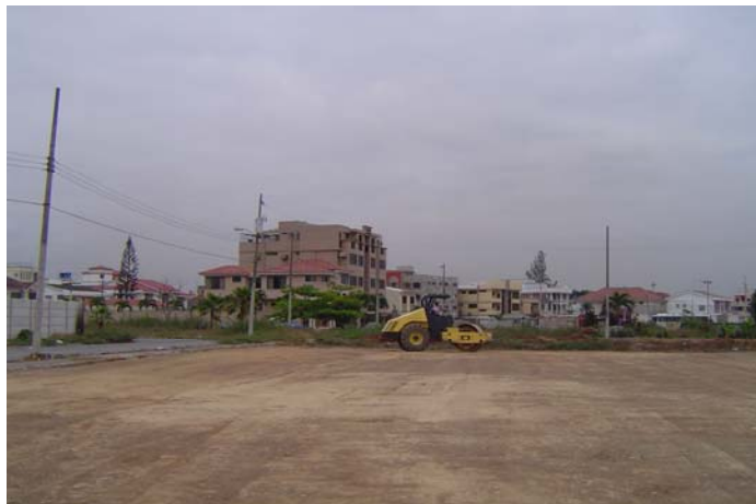
Figura No 2.3 Compactado y Nivelación
