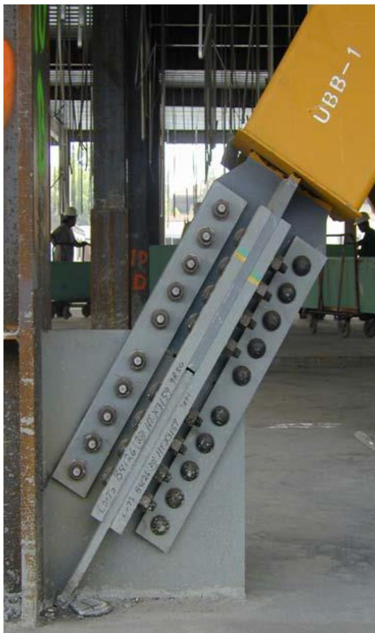
**Figura 2.26.** Conexión emperrada estándar de un APR (Hussain, et al., 2006)
