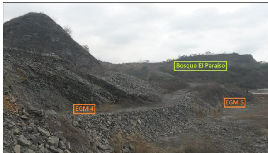
Figura 41 Ubicación de estaciones geomecánicas (4 y 5)
