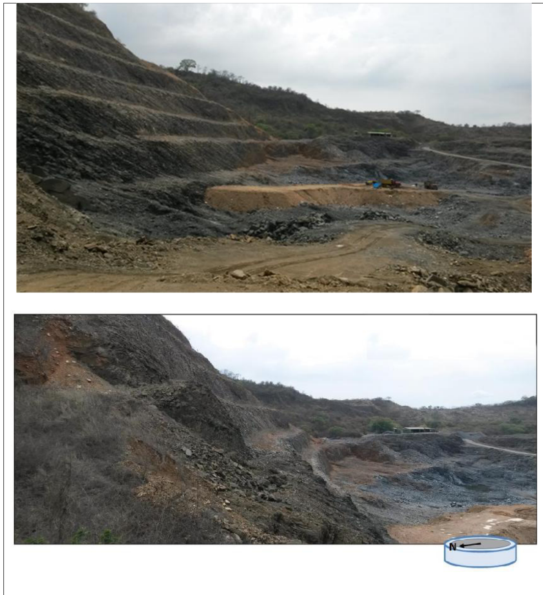
Figura 85 Vista Panorámica del Talud de estudio.
