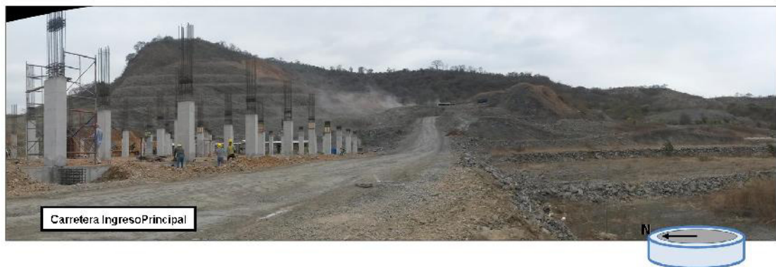
Figura 86 Construcción del Complejo Hospitalario 'Interhospital'.
