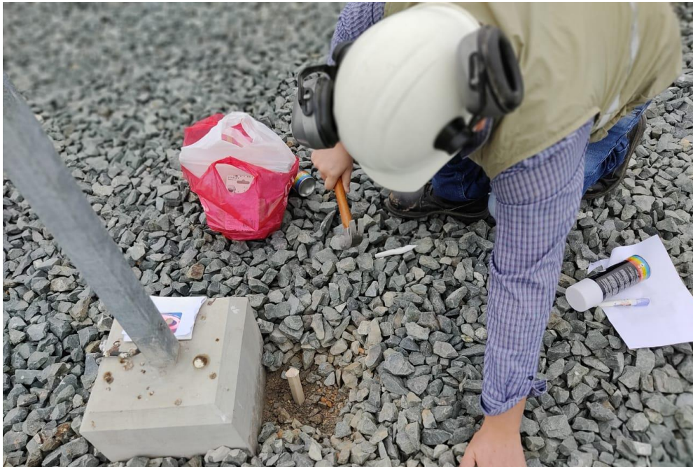
Anexo 4 Instalación de puntos para lectura de asentamientos
