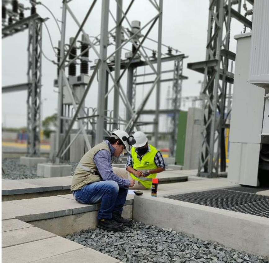
Anexo 5 Instalación de puntos para lectura de asentamiento
