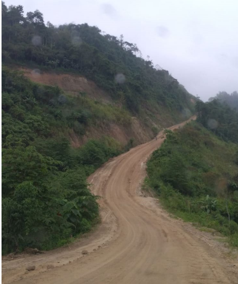
Figura 3.6 Talud de roca 19+980. Fuente: Autor.
