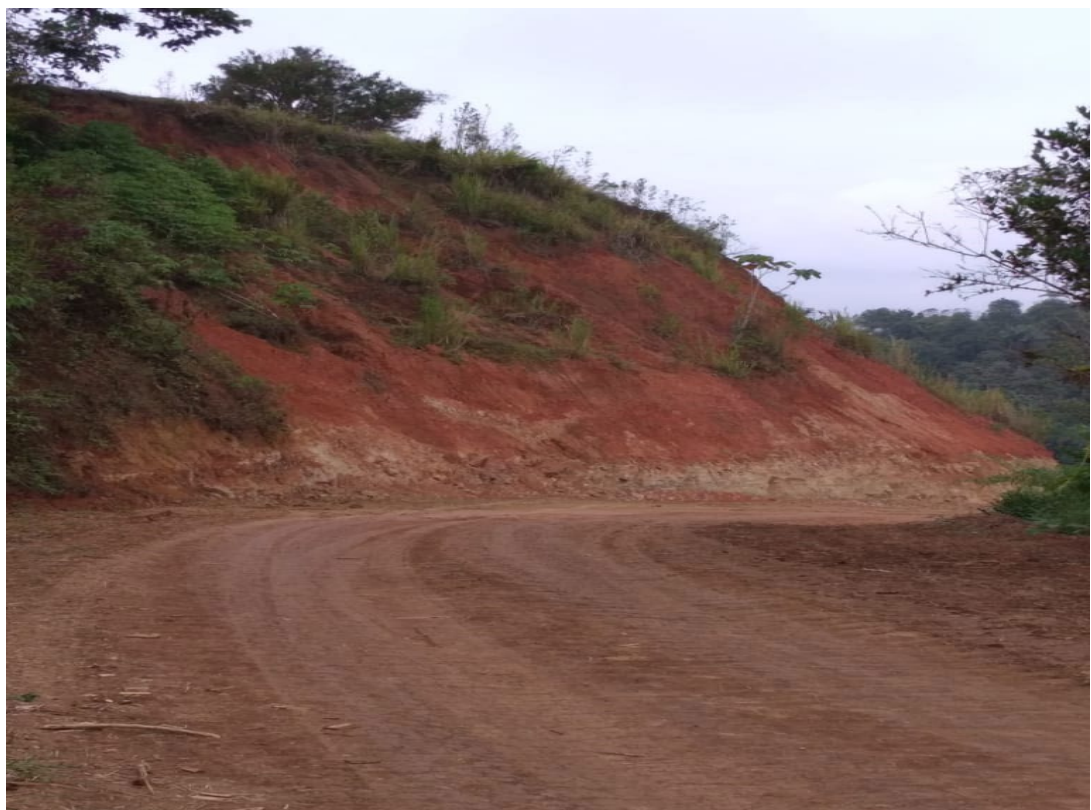
Figura 3.9 Talud de roca 25+280. Fuente: Autor.
