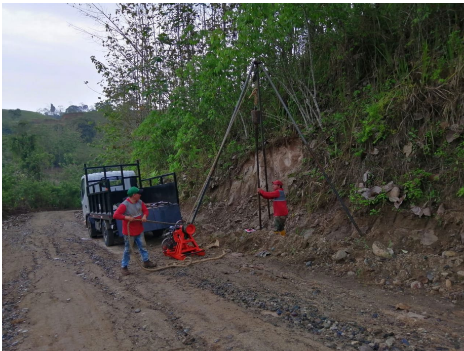
Figura 3.17 Ejecución del ensayo de SPT. Fuente: Suelcon & Asf.
