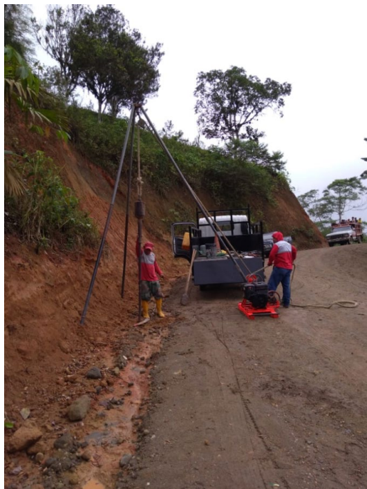
Figura 3.13 Ejecución del ensayo de SPT en el talud 25+280. Fuente: Suelcon & Asf.
