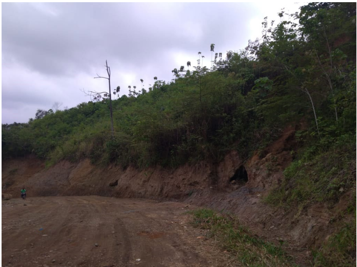
Figura 3.12 Talud de roca 25+280. Fuente: Autor.
