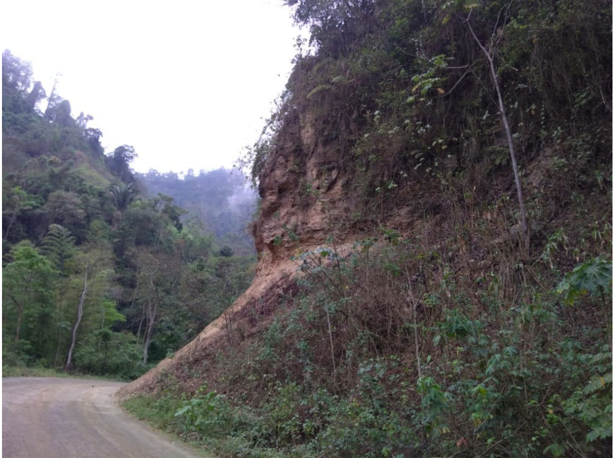
Figura 3.3 Talud de roca 7+900. Fuente: Autor.
