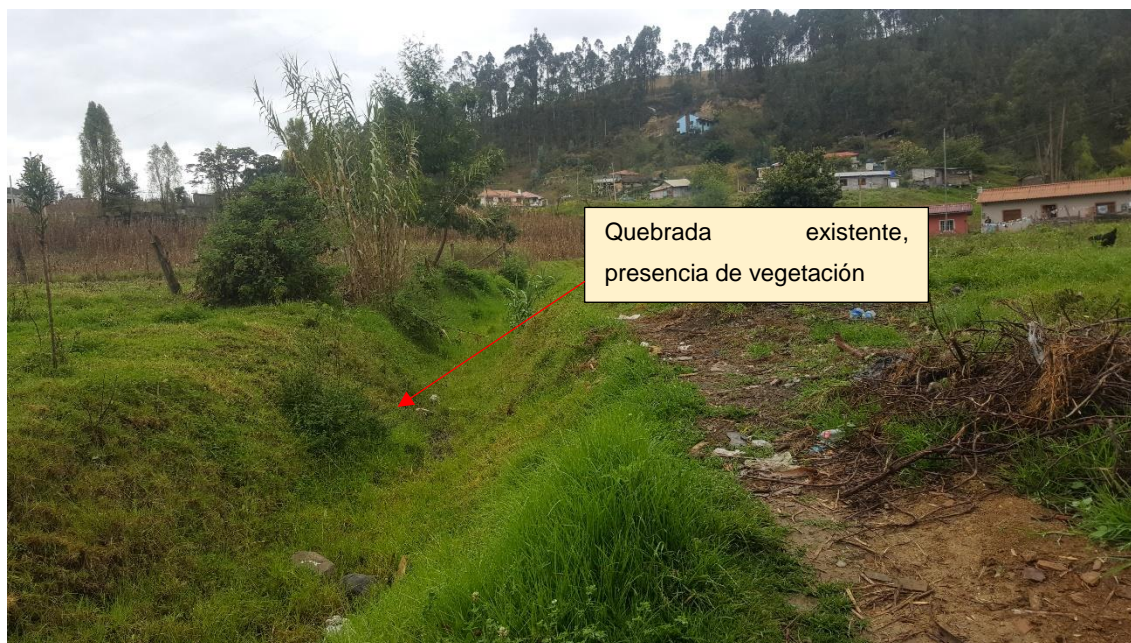
Figura 1.4 Presencia de vegetación en cauce natural de quebrada existente, flanco occidental del deslizamiento (Fuente: Autor)
