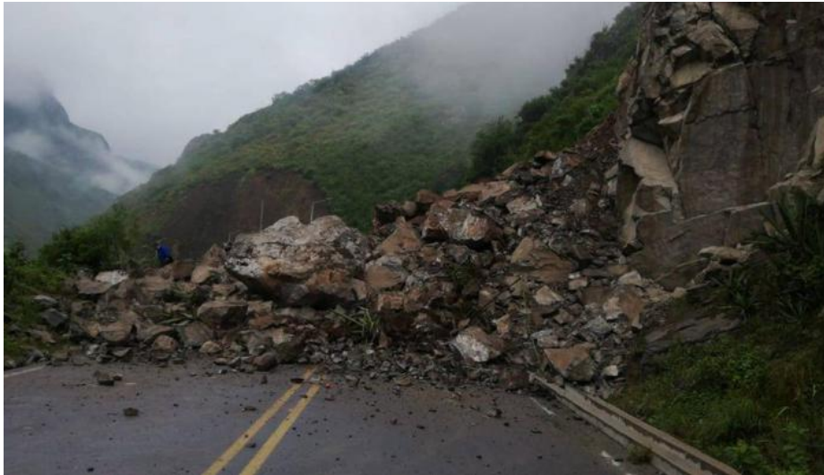
Figura 3: Deslizamiento en la vía Cuenca – Girón – Pasaje (Diario Expreso, 2019).
