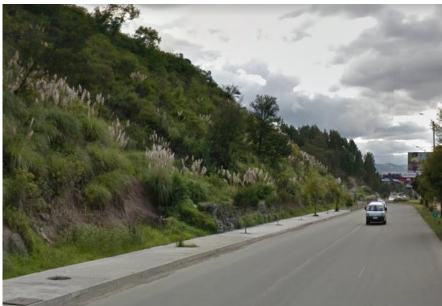
Figura 39: Muro de contención de pie del talud IESS, fuente: GOOGLE EARTH.
