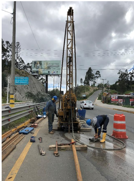
Figura 22: Perforación geotécnica sector 12 de Octubre, PO5 (MTO, 2021).
