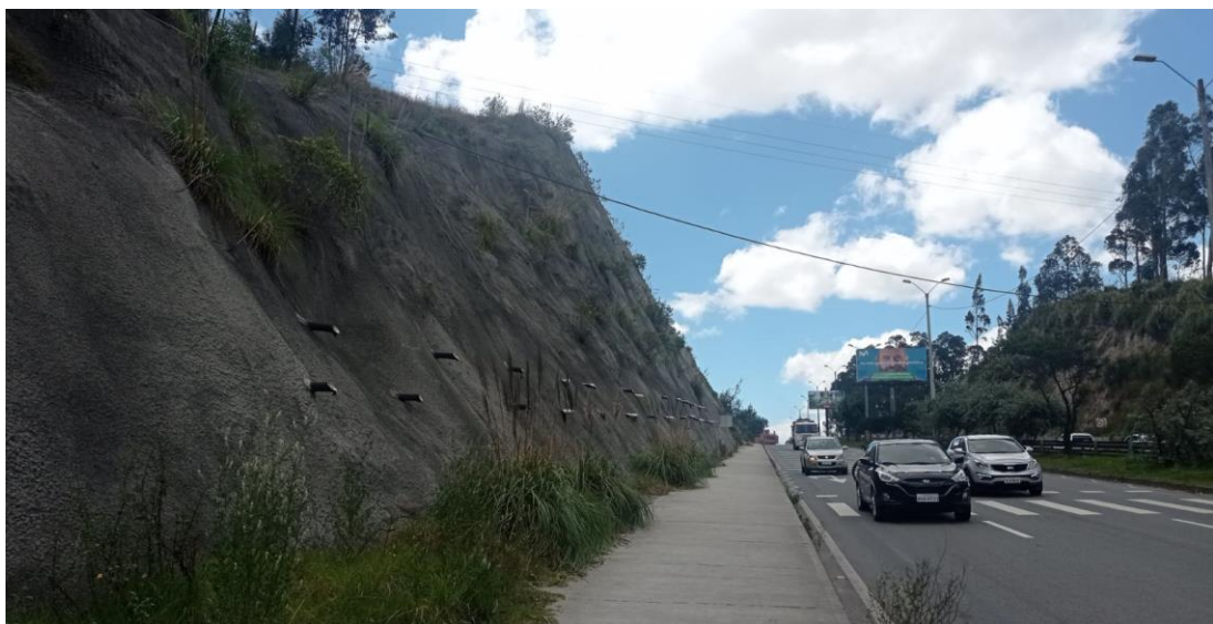
Figura 18: Estado actual, talud redondel 12 de Octubre.
