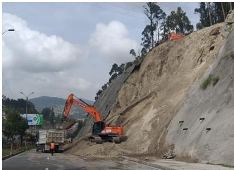
Figura 2: Estabilización de talud en el redondel 12 de Octubre (Ministerio de Transporte y Obras Públicas, 2019)
