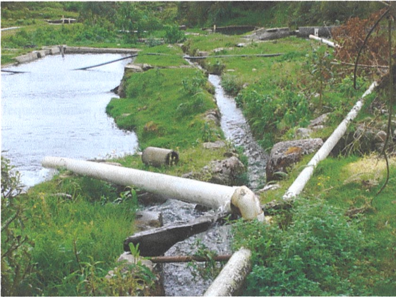
Figura # 6 . CANALES DE AGUA EN TIERRA
