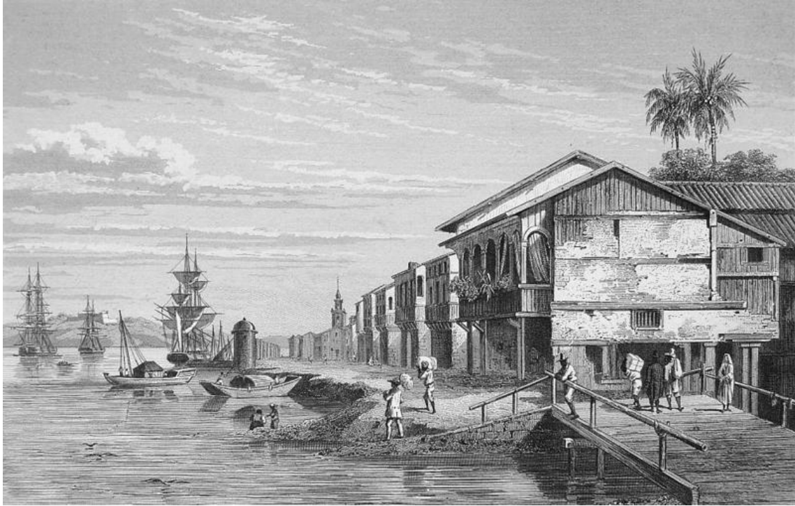
Figura 3-36: Ilustración de los edificios construidos al comienzo del malecón.
