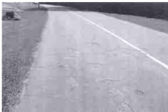
FOTO No. 4.53.- Falla Intemperismo – Severidad Alta
