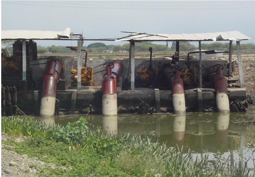
**FIGURA 1.3 ESTACIÓN DE BOMBEO CON CUATRO MOTORES
