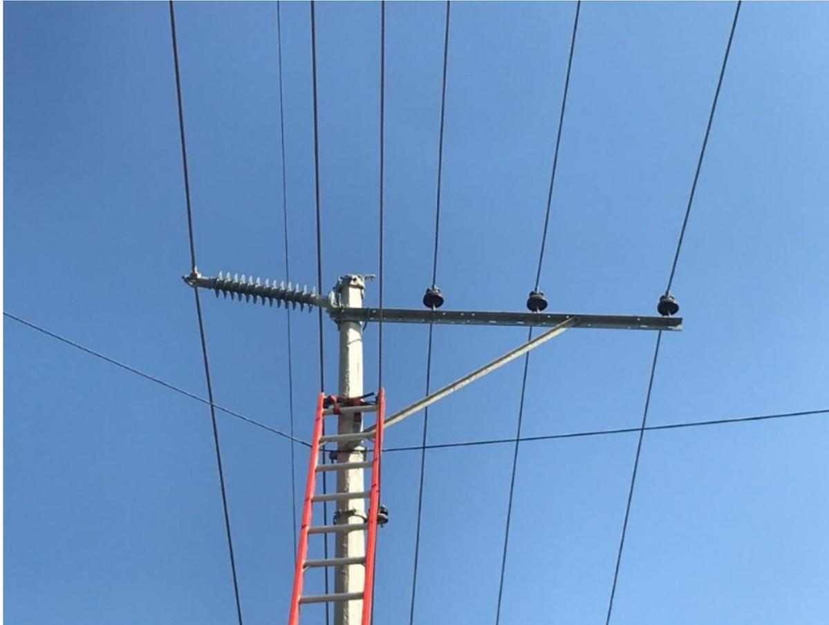
**Fig. 4.2: Trabajo correctivo provisional por Falla en Línea de Subtransmisión Quinto Guayas por no ejecutar intercalación de poste**
