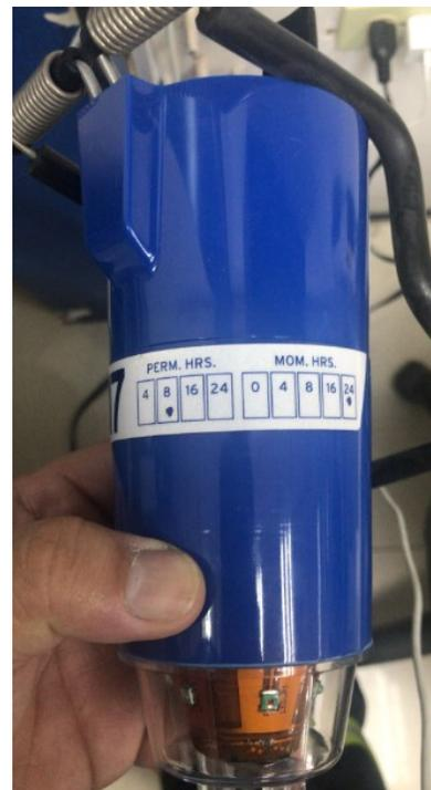
**Fig. 4.7: Tiempo de reseteo automático de indicador en caso de falla permanente: 8 horas. Tiempo de reseteo automático en caso de falla temporal: 24 horas.**
