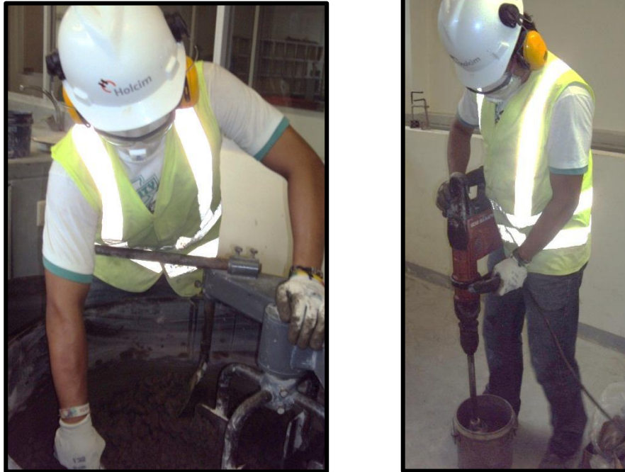
Ilustración 4. 12 Mezclado y Compactación de Materiales.
