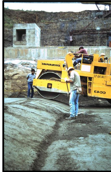
Ilustración 8. 16 Consistencia y Compactación del HCR, Tomado de la Presentación: Errores, Aciertos, Contrariedades, Conquistas y Necesidades de Mantener la Calidad- Ing. Francisco Rodríguez.
