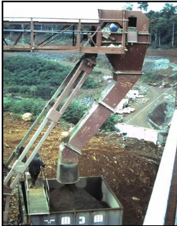
Ilustración 7. 13 Llegada del Hormigón por Medio de Cinta Transportadora, Tomado de la Presentación: HCR Evolución y Nuevos Horizontes - Ing. Miguel A. Golik.
