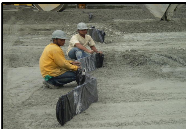
Ilustración 8. 14 Placa para Darle Irregularidad a las Capas Verticales, Tomado de la Presentación: HCR Evolución y Nuevos Horizontes - Ing. Miguel A. Golik.
