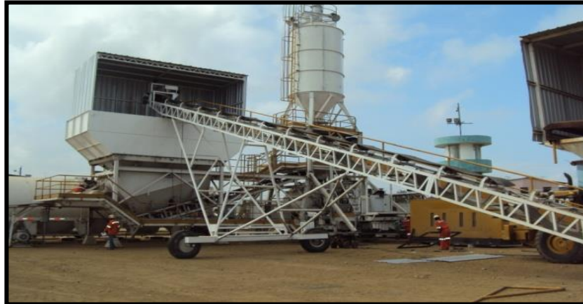
Ilustración 7.4 Almacenaje de Agregados Planta de HOLCIM.
