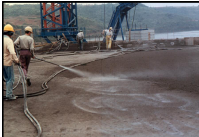
Ilustración 8. 17 Humectación de Superficie, Tomado de la Presentación: Errores, Aciertos, Contrariedades, Conquistas y Necesidades de Mantener la Calidad- Ing. Francisco Rodríguez.
