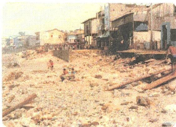
Figura 3.13b. Daños ocasionados por El Niño 1982-1983 en el malecón de La Libertad
