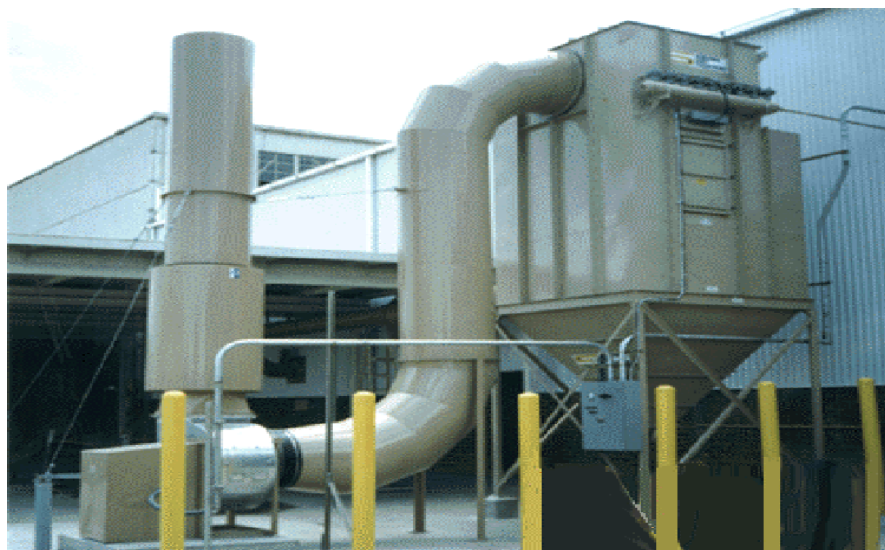
FIGURA 3.5 Filtro de mangas Pulse Jet.
