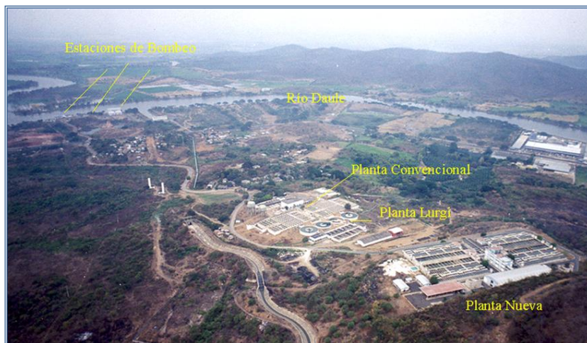
Figura 5. Planta Potabilizadora de Agua La Toma - Interagua
