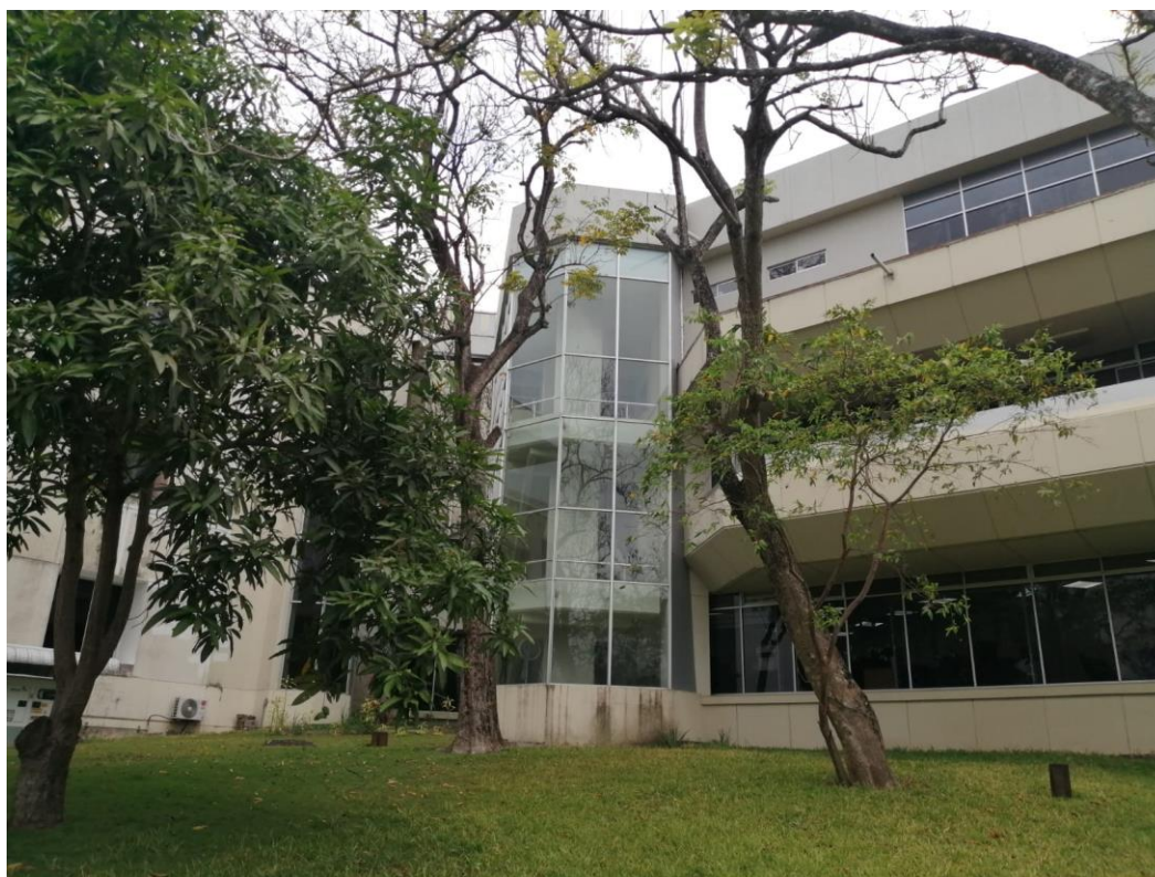
Foto 4.- Vista posterior del edificio.
