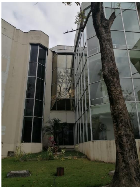
Figura 8.- Ubicación de escaleras en la fachada posterior. (Autoría propia, 2021)
