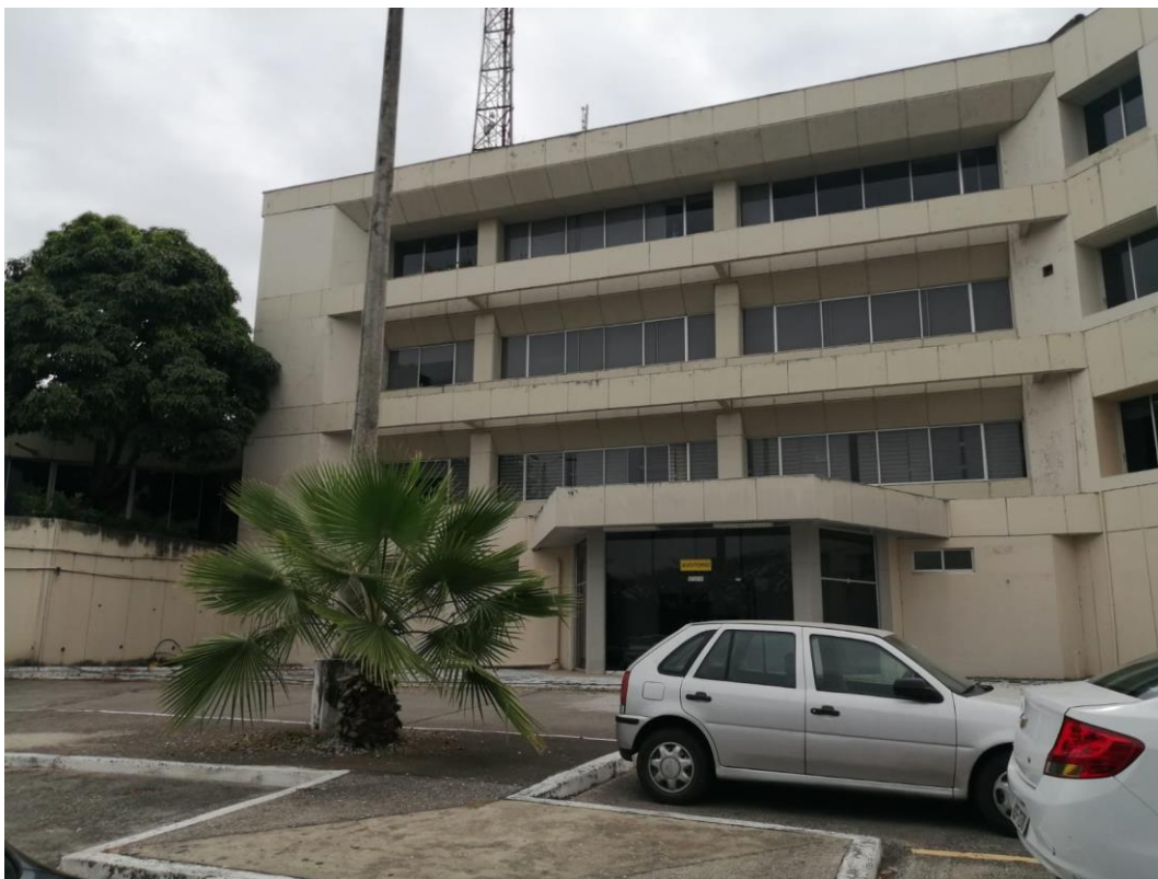
Foto 3.- Entrada al auditorio del edificio 6A.
