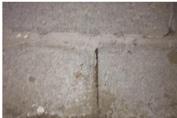
Figura 3.1-19 Evidencia fotográfica de las paredes interiores del edificio [Fuente (Autor Propio)].
