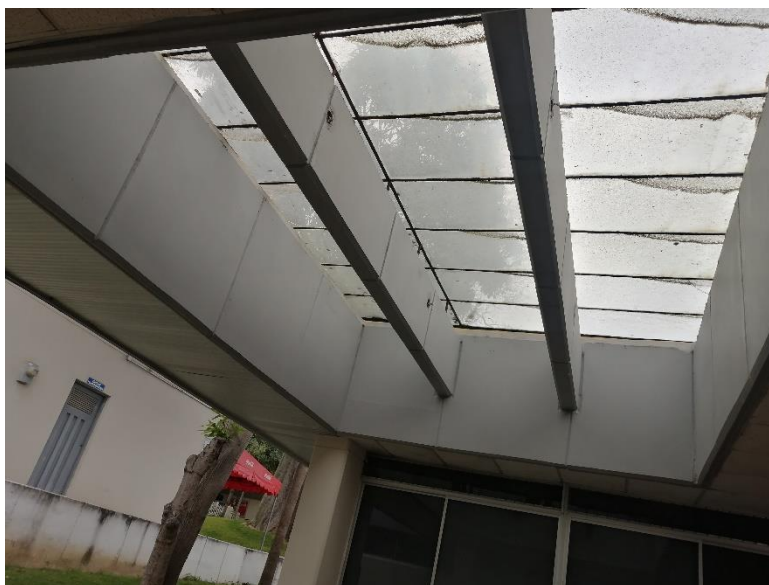
Figura 2.2-3 Verificación de la luz natural del Edificio Decanato FICT [Fuente (Autor Propio, 2021)].
