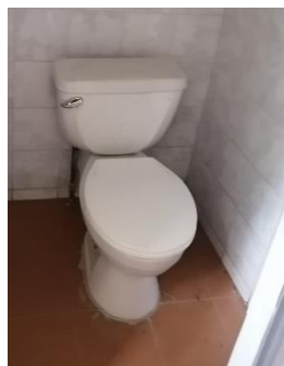
Figura 3.1-10 Modelo de los sanitarios actuales del Edificio Decanato FICT [Fuente (Autor Propio, 2021)].
