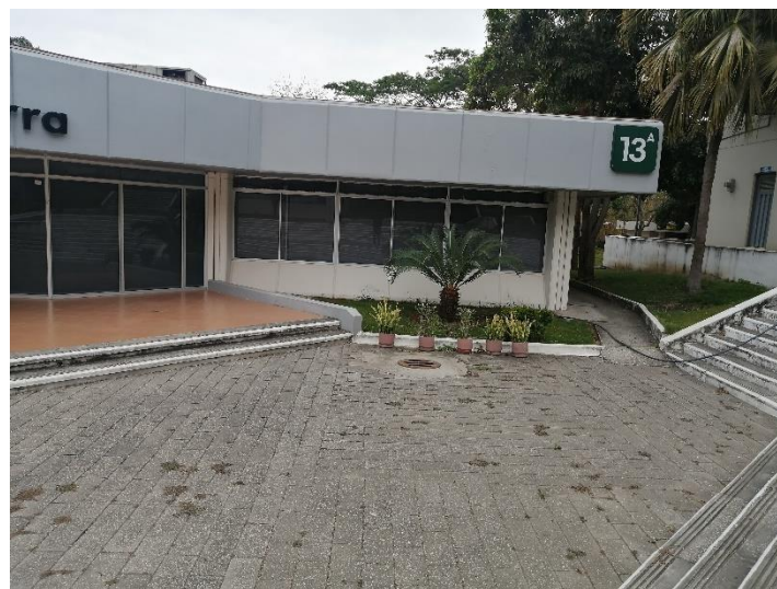
Figura 2.2-5 Verificación fachada principal e identificación tipo de losa [Fuente (Autor Propio, 2021)].
