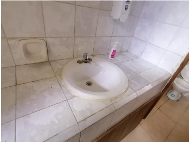
Figura 2.2-6 Lavamanos actuales en el Edificio Decanato FICT [Fuente (Autor Propio, 2021)].
