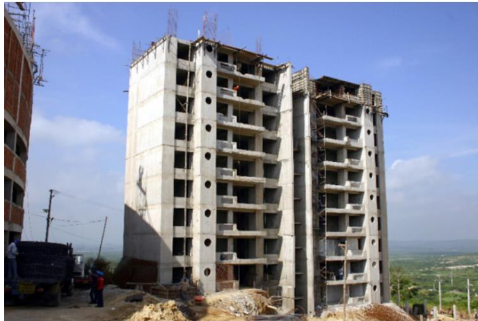
Figura 2.4: Sistema Estructural dual (Silva, 2020)
