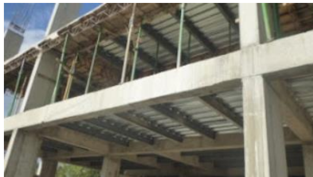
Figura 2.5: Sistema estructural mixta de acero-hormigón (Muñoz, 2021)
