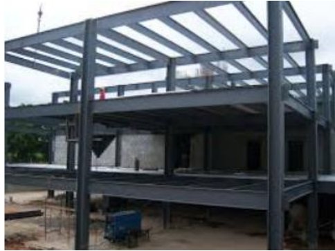
Figura 2.6: Estructura de acero estructural (Muñoz, 2021)
