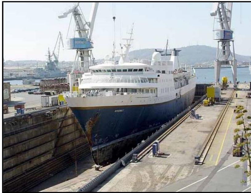
Figura 1. 1. Dique Seco de El Ferrol
