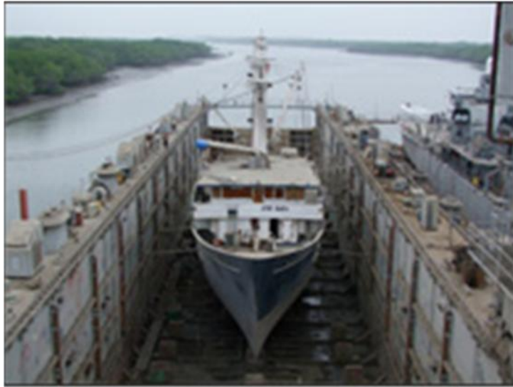
Figura 1. 2. Dique Flotante Río Orellana
