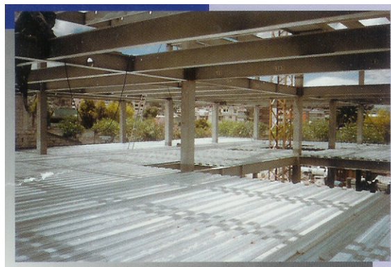
FIGURA 7. PRODUCTO TERMINADO (NOVALOSA).
