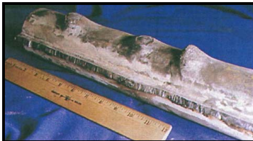
FIGURA 1.9. COMBAS MÚLTIPLES Y BRUSCAS SOBRE LA CARA CALIENTE DE UN TUBO DE PANTALLA. (FUENTE: GUIA NALCO PARA EL ANALISIS DE FALLA EN CALDERAS)
