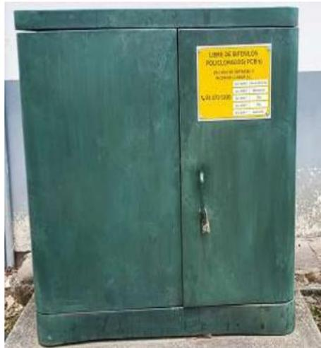
Figura 2.4: Transformador de 300 kVA que alimenta a la bomba contra incendios
