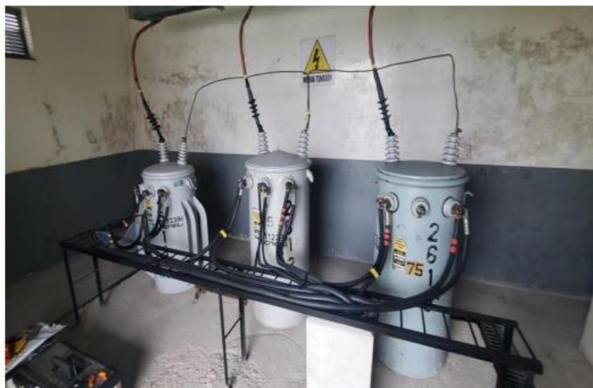
Figura 2.3: Banco de transformadores de 250 kVA que alimenta a la planta Pifo.
