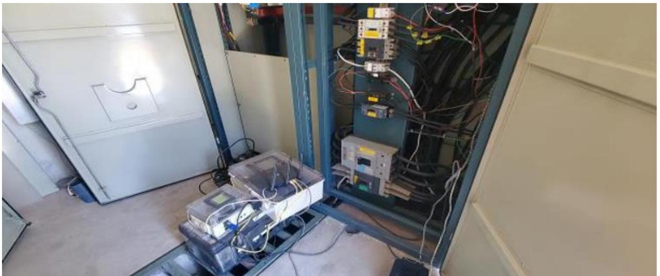
**Figura 2.8: Instalación del analizador de redes en la salida del breaker de 600 A**
