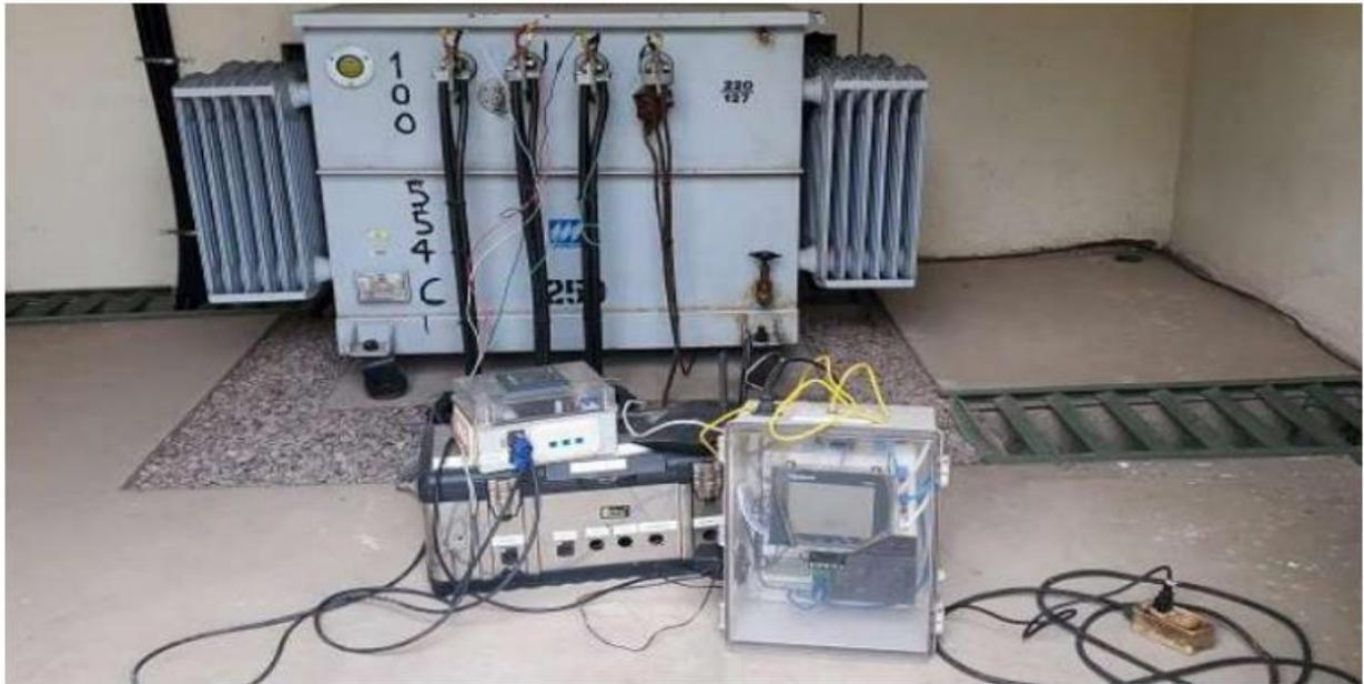
**Figura 2.7: Instalación del analizador de redes en la salida del transformador(imagen referencial de la planta de Santo Domingo)**
