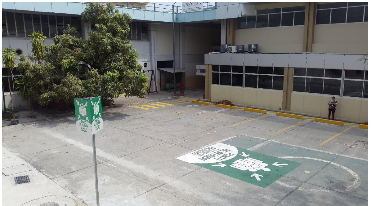
FIMCP: Laboratorio de Termofluidos / Edificio STEM
