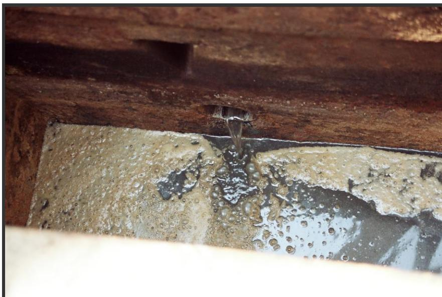
**Fotografía 3.** Trampa de grasas para el efluente industrial.
