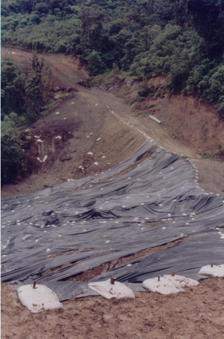
**Protección del material extraído durante la excavación del DDV con mantos plásticos y sacos llenos de suelo**
