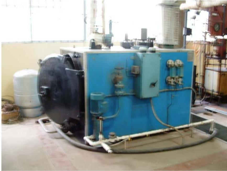
**FIGURA 6.1.1. Caldera de 30 BHP a diesel marca THOMPSON COCHRAN BOILERS**
