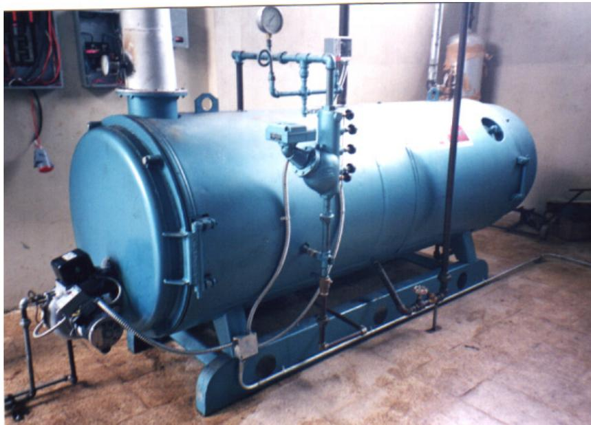
**FIGURA 6.1.2. Caldera de 50 BHP a diesel marca ADUM CONSTRUCCIONES MECÁNICAS**
