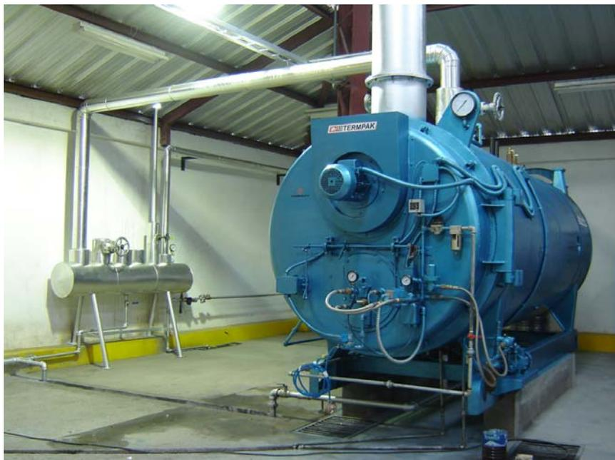
**FIGURA 6.1.3. Caldera de 150 BHP a diesel marca TERMPAK**
