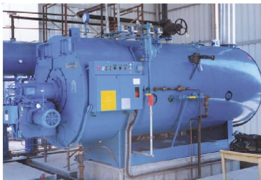
**FIGURA 6.1.4. Caldera de 200 BHP a búnker marca YORK SHIPLEY**
