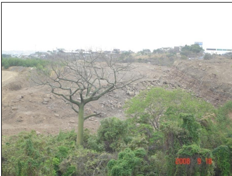
Figura 1: Estribo izquierdo de presa, se puede apreciar los estratos
