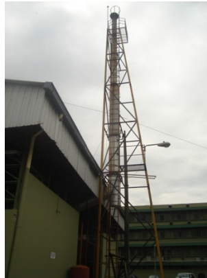
Fig. 1-15 Chimenea del Cuarto de Máquinas.
